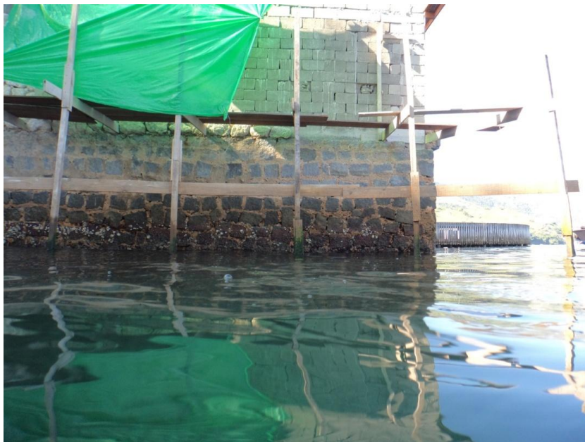
Figura 7: Vista lateral do muro, com estrutura temporária auxiliar à obra, promovendo sombreamento nos transectos 1 e 2, do sítio 1.
